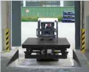
הרכבת גשר ההעמסה החדש
