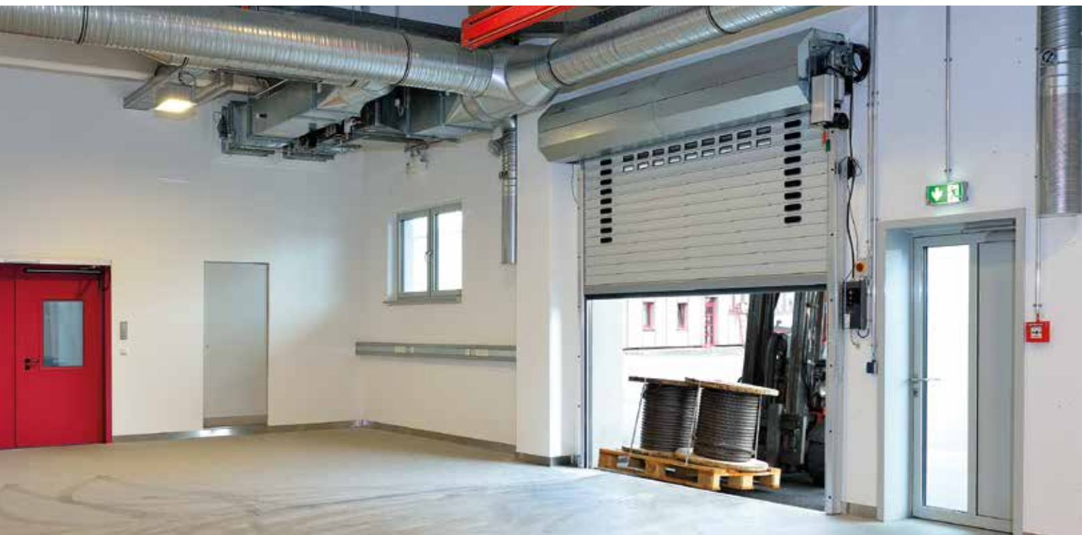
מהירות הפתיחה והסגירה הגבוהה של עד 1.1 מטר לשנייה מייעלת את תהליכי ההפעלה ומפחיתה את הפסדי החום.
